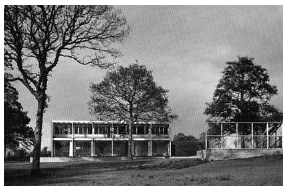
Fig. 19 - Casa Bentley Wood - fachada Fonte: Álvares, 2007, p.155
