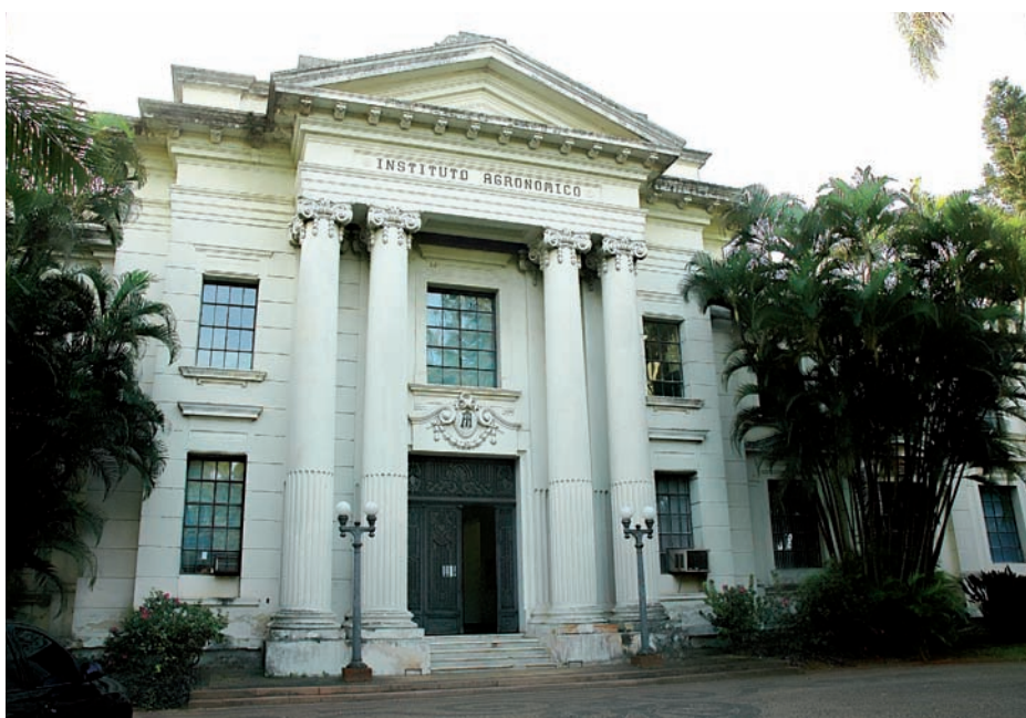
Fachada do prédio D. Pedro II do Instituto Agronômico de Campinas.
