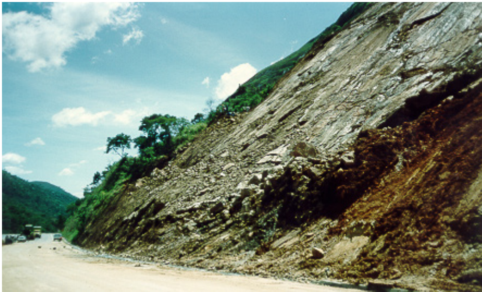
Figura 89 - Movimento de massa às margens da Rodovia BR-040, no Município de Petrópolis (RJ).
